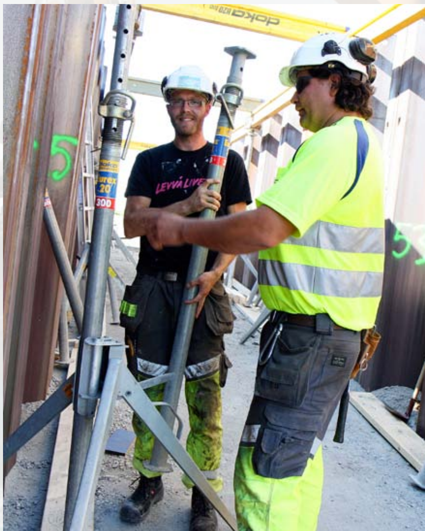
– Smart gjør arbeidsdagene langt mer forutsigbare og effektive, mener armeringsarbeider Anders Sæterhaug (t.v.) og bas Ole Nikolai Sand.
