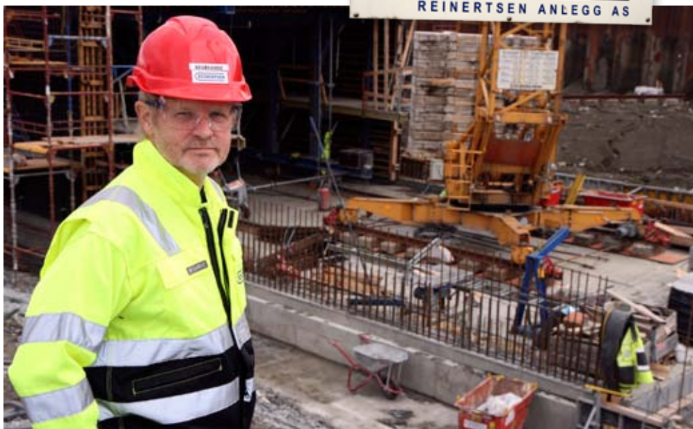
På Tangen i Stjørdal legger Reinertsen AS E6-en i en 500 meter lang kulvert for å åpne tilgangen til strandsonen. I samarbeid med NTNU driver entreprenøren prosjektet etter Smart-konseptet. Det har gitt mer effektive arbeidsprosesser og bedre kvalitet. Her er Smart-sjef og forskningsleder Lars Andersen ved NTNU Samfunnsforskning AS.
